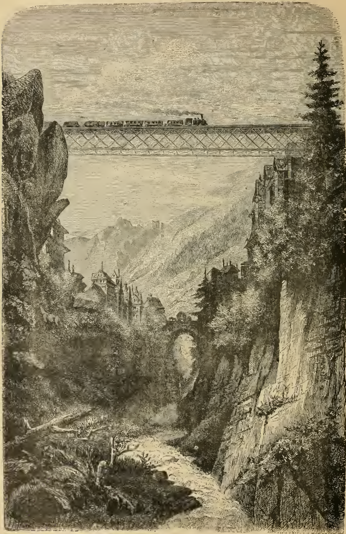
FIG. 115. — PONT-VIADUC SUR LA REUSS, A GOESCHENEN
